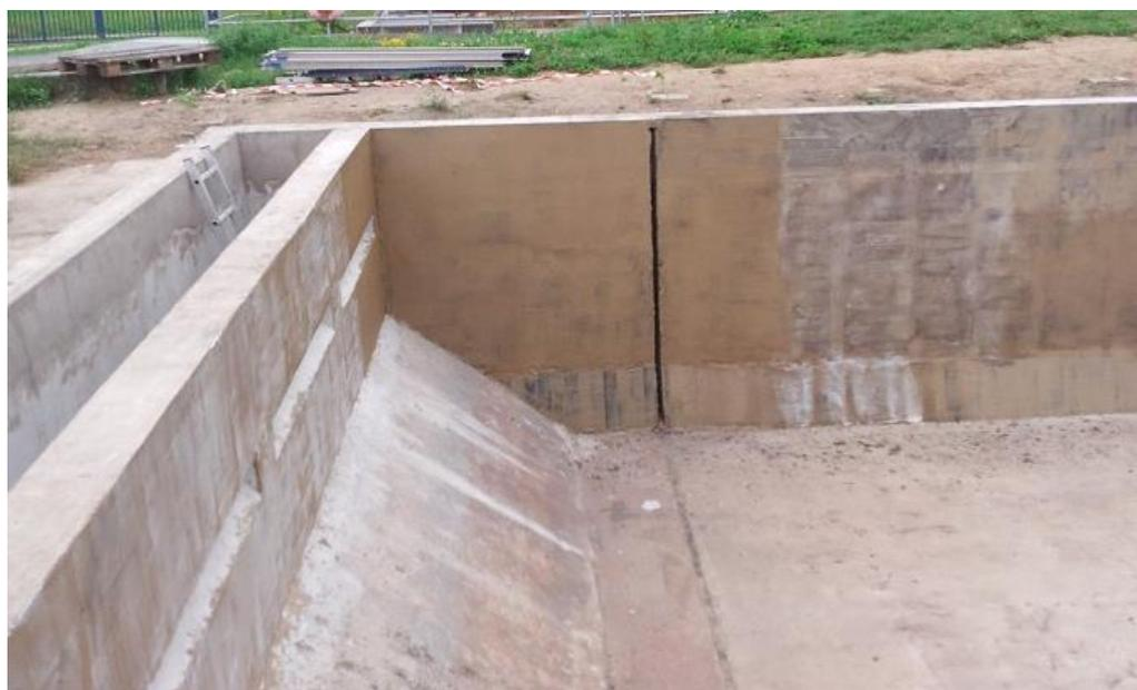
プライマー塗布後、重防食塗料としてセラム CN-200 をエアレス塗装機で吹き付け塗装しました。
