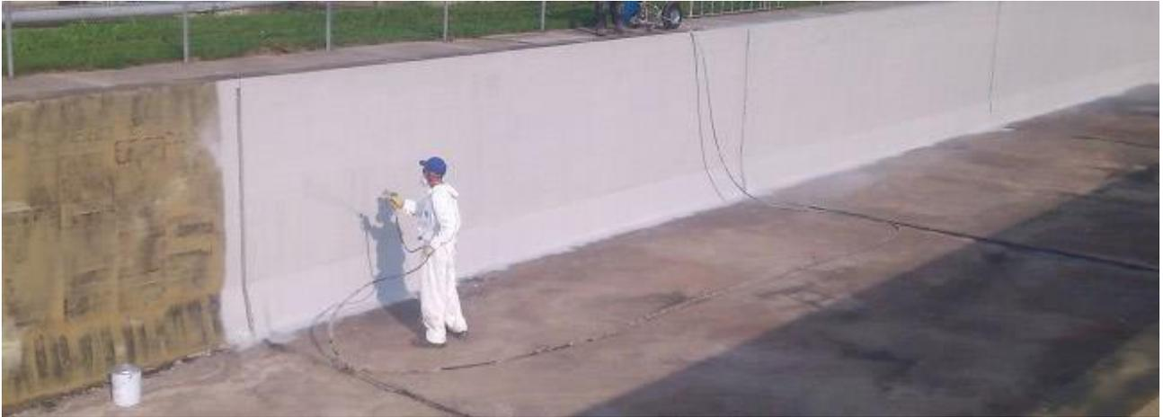
ドイツ東北部 Radeburg 市の下水処理場では、セラムを使った大規模な補修工事が行われました。この下水処理場では、コンクリート製の汚水の調整槽が、短期間で破損、腐食を繰り返してきました。都度、小規模の部分補修を行っておりましたが、この度セラムを使い大規模な内面の補修・再防食工事を行いました。
