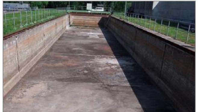
補修工事に先立ち、まず、全てのコンクリート面・壁面・床面にブラストをかけました。これにより腐食、破損したコンクリート部分が露出。破損部分のコンクリート・骨材片は完全に除去されました。この結果、部分的に内部鉄筋が露出した箇所もありました。
