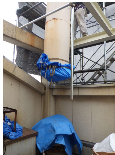
煙突切断完了
