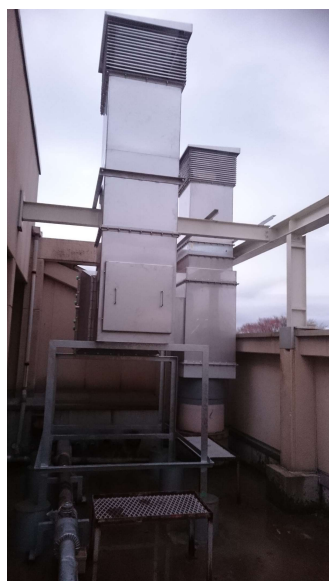
新規煙突設置完了
