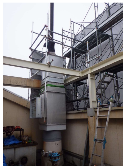
新規煙突設置
